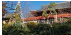
▲当社の施工事例 (上野寛永寺清水観音堂での松の手入れ)
